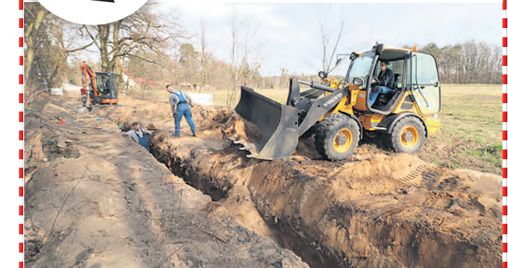
Jährlich investiert der WAZV in die Infrastruktur seiner Anlagen und Netze. Foto: SPREE-PR/Petsch
