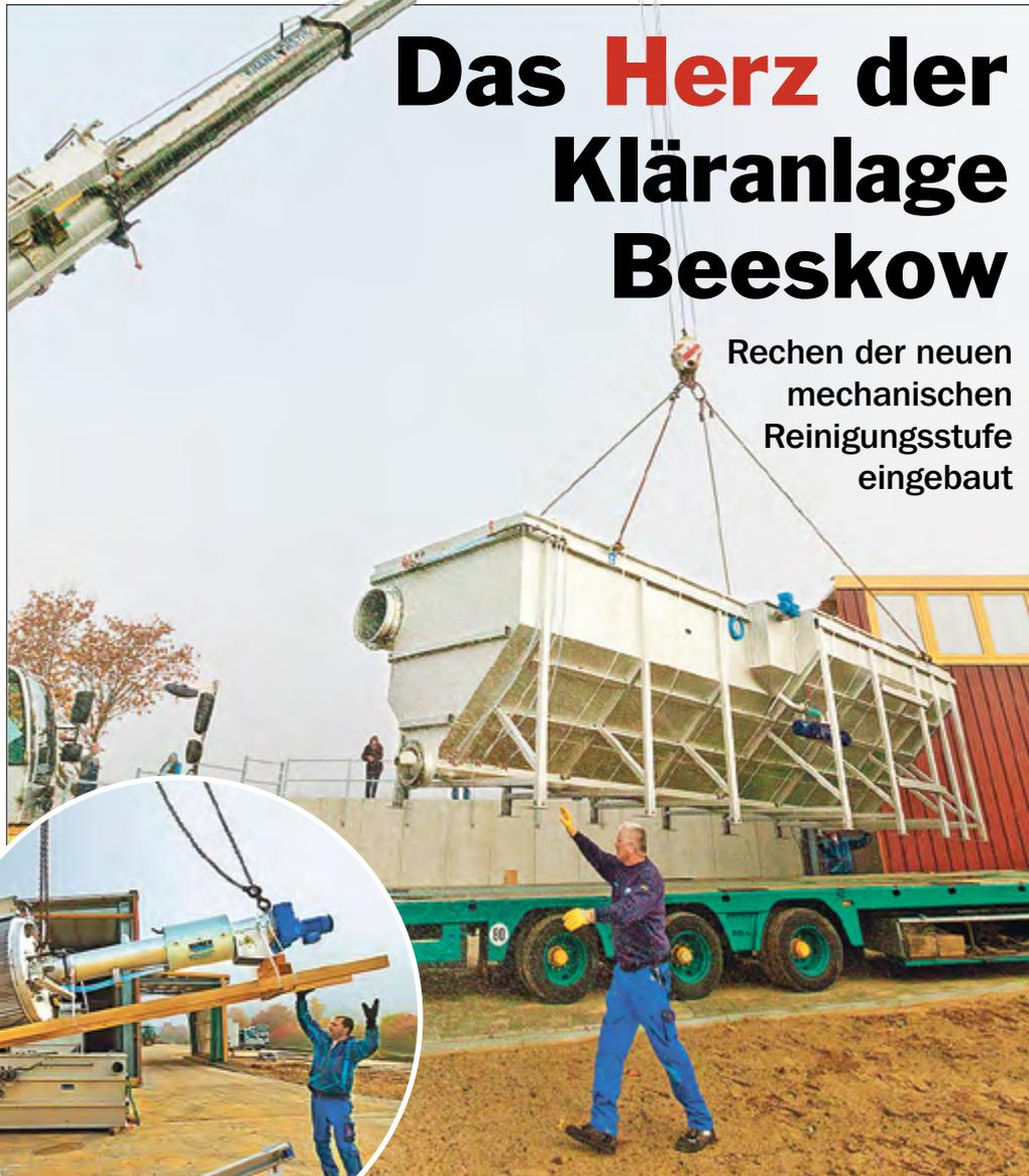
**Schwebend erreicht der vier Tonnen schwere Rechen sein Ziel. Das Herzstück der Anlage: die Siebtrommel (kleines Foto).** Fotos: SPREE-PR/Petsch
