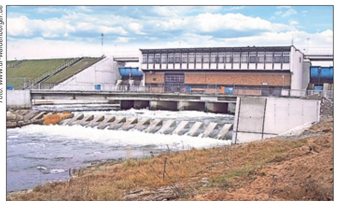
Eingebunden in den Erdstoff-Staudamm des Spremberger Stausees birgt die größte Wasserkraftanlage Brandenburgs eine Nennleistung von mehr als 1 MW. Die von 1958 bis 1965 vorrangig für den Hochwasserschutz gebaute Flachlandtalsperre ist eine technische Pionierleistung.
