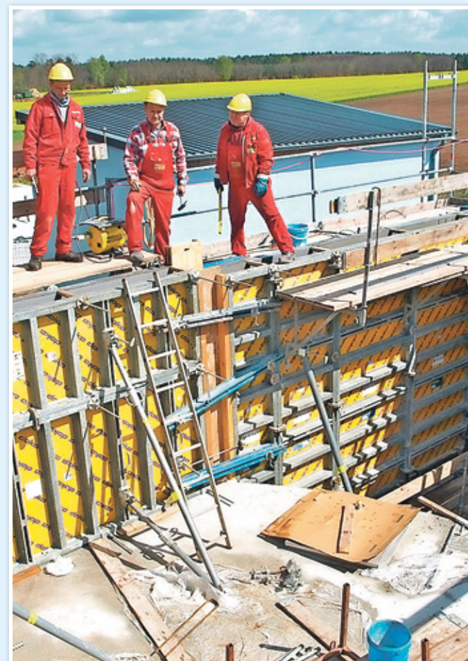
Die Spezialisten der Firma SBB Beutler & Lang GmbH & Co. kennen sich beim Schalungs- und Behälterbau bestens aus. Anfang Mai wurde im Wasserwerk Görzig die Form für den Reinwasserbehälter gegossen und ummantelt.
