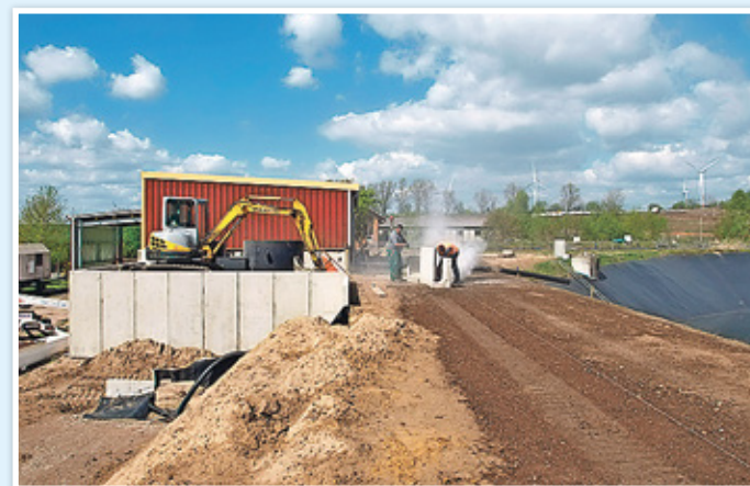
Auf der Kläranlage Beeskow gehen die Arbeiten voran – links das neue Rechengebäude, rechts Überlauf- und Pufferbecken.
