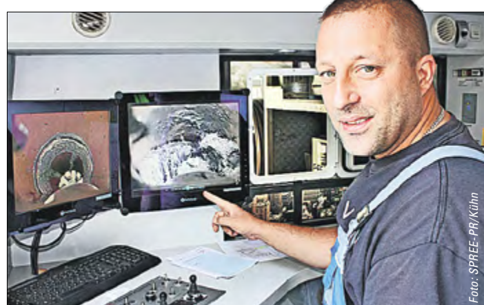
Mario Raab von der Firma Fleeer-Tech sieht über die Monitore vom Wageninneren aus, wo unterirdisch Handlungsbedarf besteht. Wenn er die Verkrustungen gelöst hat, können sogenannte Kurzliner auf die jeweiligen Schadstellen geklebt werden und diese versiegeln.
