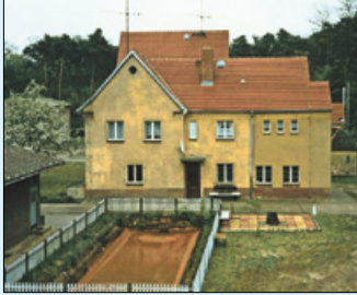
Das Wasserwerk Beeskow vor ...
