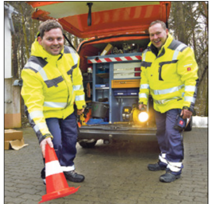
Carsten Luka (links) und Torsten Witt errichten eine Straßenabsperzung, um einen Rohrbruch zu beseitigen.
