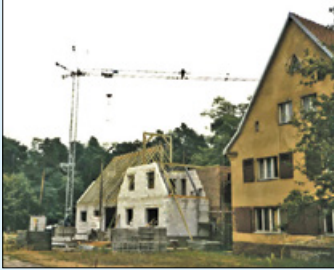
Bau des Verwaltungsbäudes im Jahr 1922.
