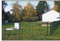
Wasserwerk Buckow nach der Rekonstruktion.
