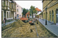
Auswechslung der Leitung in der Berliner Straße in Beeskow.
