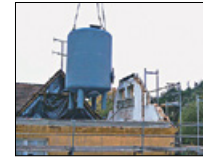
Montage der Filterkessel im Wasserwerk Beeskow.
