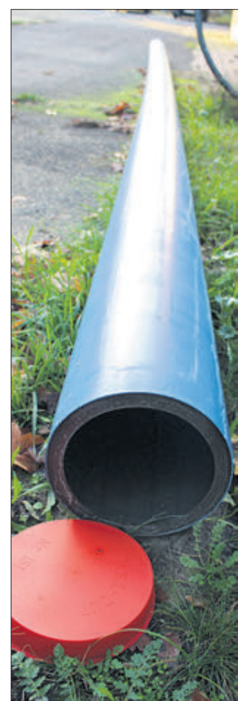
Durch dieses PE-Rohr wird nach der Verlegung ins Erdreich ebenfalls das Trinkwasser des WAZV fließen. Foto: SPREE-PR/Kühn
