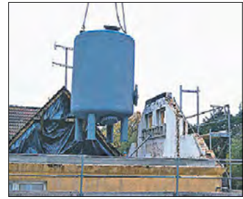
Montage der Filterkessel im Wasserwerk Beeskow.
